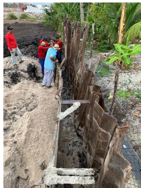
Escoramento Metálico – Cony Engenharia
